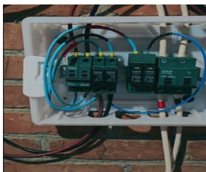
Рисунок 3 – Комплект гибридной системы питания дома
