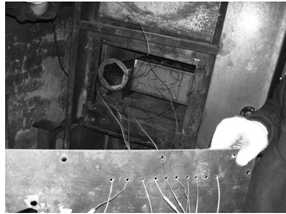
б – установка теплогенератора в печи
